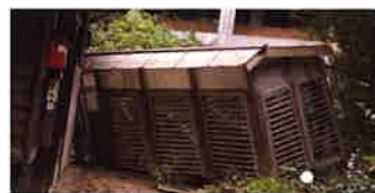
解体した小屋。元の場所から 10m 程流され道路を塞いでいた。
